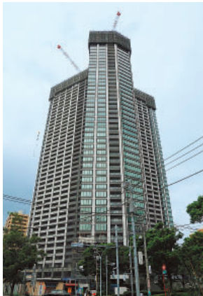
勝どき五丁目地区第一種市街地 再開発事業施設建築物等新築工事 (シーリング防水工事)
