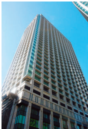
東京日本橋タワー (メンブレン防水工事等)
