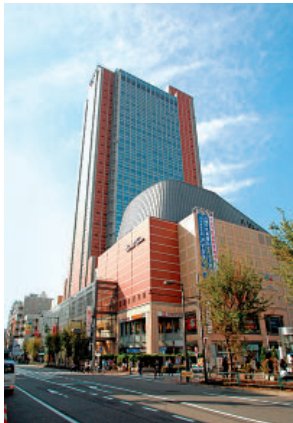
キャロットタワー (リニューアル工事)
