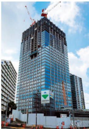
大久保三丁目西地区A-1 (メンブレン防水工事等)
