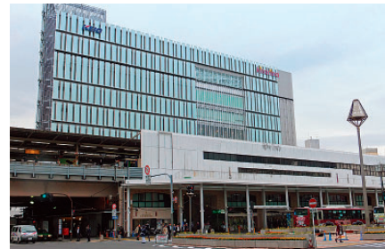
京王吉祥寺駅ビル建替工事（開発推進）その1 (リニューアル工事)
