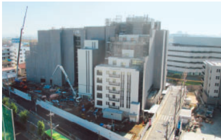
(仮称) 小豆沢1丁目計画 西敷地 新築工事 (メンブレン防水工事等)
