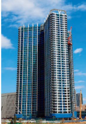
(仮称) 豊洲3-2街区開発計画 (シーリング防水工事)
