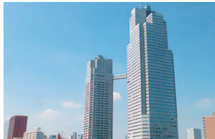
聖路加ガーデンオフィス棟レジデンス棟外壁シーリング更新工事 (リニューアル工事)
