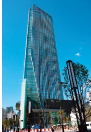
虎ノ門ヒルズ (シーリング防水工事)
