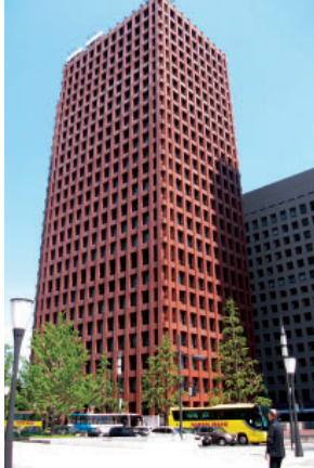
東京海上日動ビル本館 外壁改修工事 (リニューアル工事)
