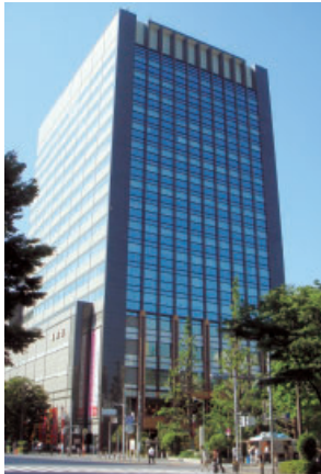
浜町センタービル 外装改修工事 (リニューアル工事)
