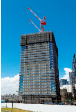
(仮称) 中央区晴海マンション 計画第1期C1街区 (シーリング防水工事)
