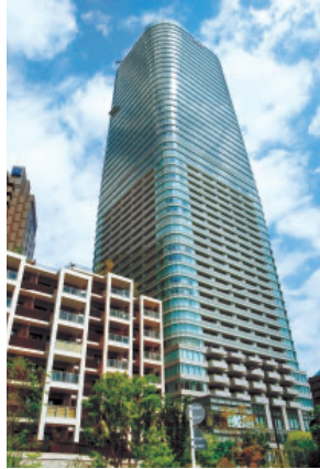
アークヒルズ仙石山森タワー (メンブレン防水工事等)
