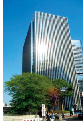
御茶ノ水ソラシティ (シーリング防水工事)
