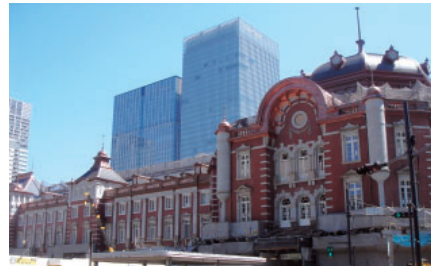
東京丸の内駅舎 保存・復原工事 (リニューアル工事)
