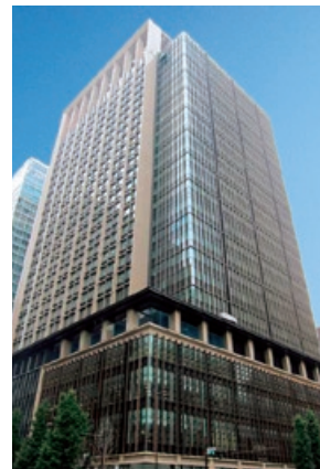
丸の内1-4計画 (シーリング防水工事)
