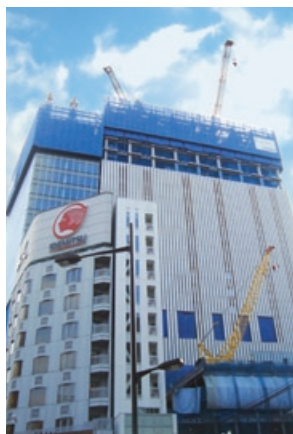
KS計画(歌舞伎座) (シーリング防水工事)
