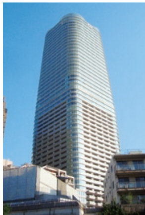
虎ノ門・六本木再開発 (シーリング防水工事)
