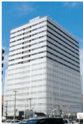
横浜西口KNビル 外壁補修工事 (リニューアル工事)
