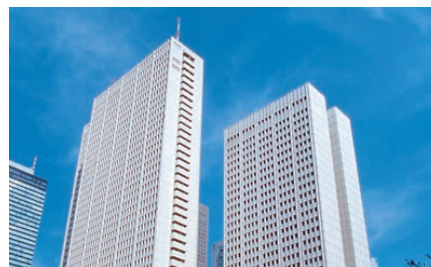
京王プラザホテル 低層外壁改修工事 (リニューアル工事)
