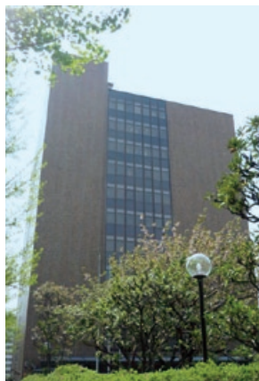
三菱東京UFJ銀行青葉台分館 外壁保全 (リニューアル工事)
