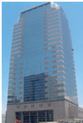
住友ケミカルエンジニアリング センタービル外壁改修 (リニューアル工事)
