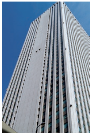
サンシャインO棟外装シール 打換工事 (リニューアル工事)
