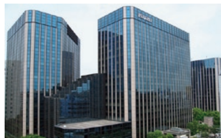
大森ベルポート3期改修工事 (リニューアル工事)
