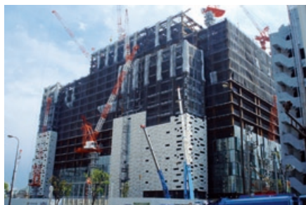
(仮称) 新宿六丁目N街区計画 (シーリング防水工事)
